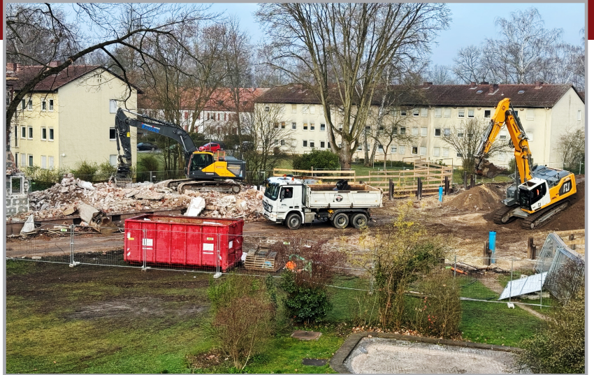
Abriss Karl-Rorich-Straße 10 und Erdarbeiten Neubau Karl-Rorich-Straße 8
