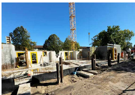
Karl-Rorich-Str. 8: Auf der Tiefgarage beginnt die Errichtung des Erdgeschosses.
