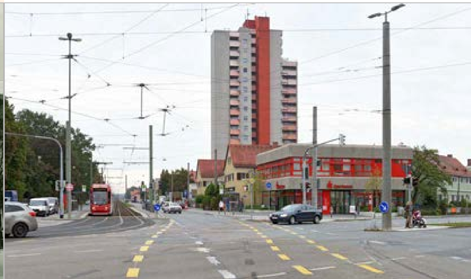
Kreuzung Finkenbrunn/Julius-Lößmann-Straße mit Sparkasse und Hochhaus.
