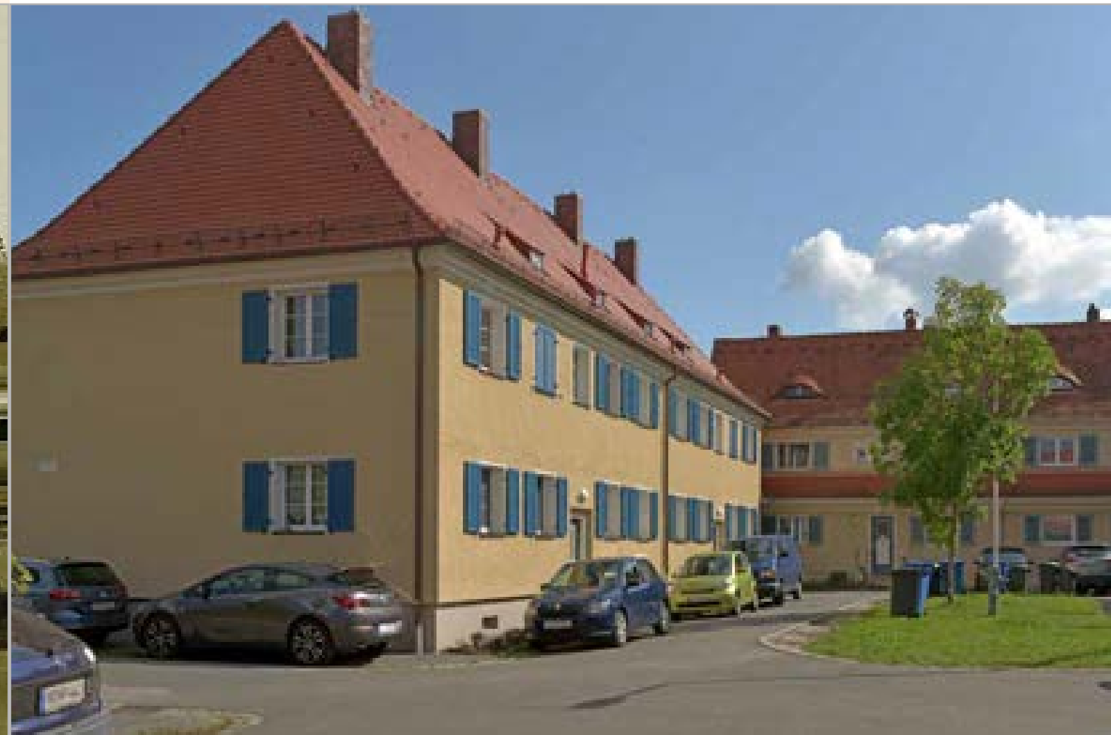
Hirschensuhl 37 - 47 Maßstabsgerechter Wiederaufbau nach der Kriegszerstörung.
