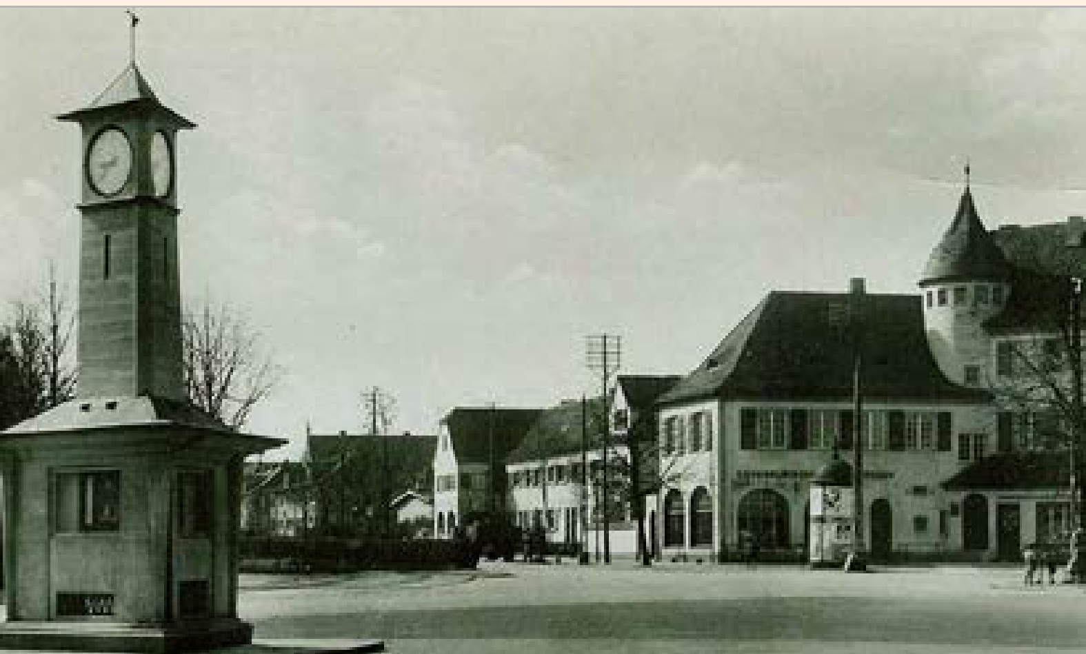
Kreuzung Finkenbrunn/Julius-Lößmann-Straße mit der alten Verwaltung
