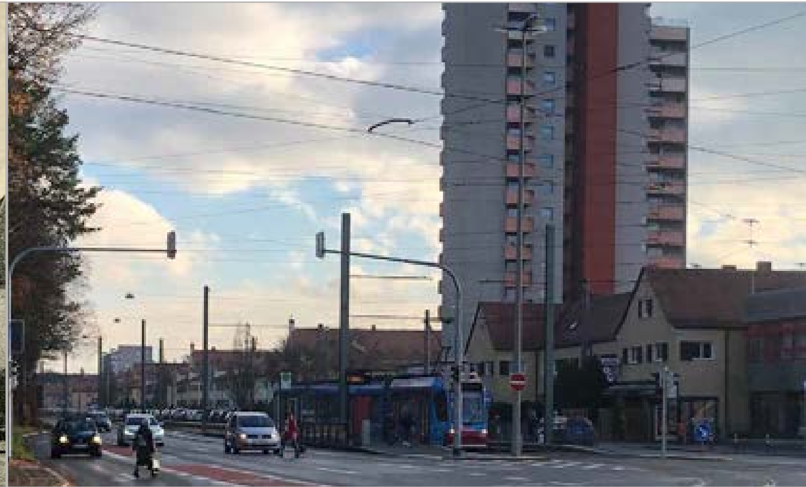
Julius-Loßmann-Straße 40 - 50 Dominiert vom Hochhaus Paumannstraße 2.
