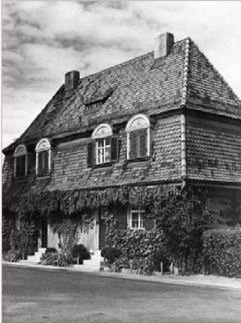
Hirschensuhl 38 - 40 Die Fensterläden waren schon damals schadhaft.
