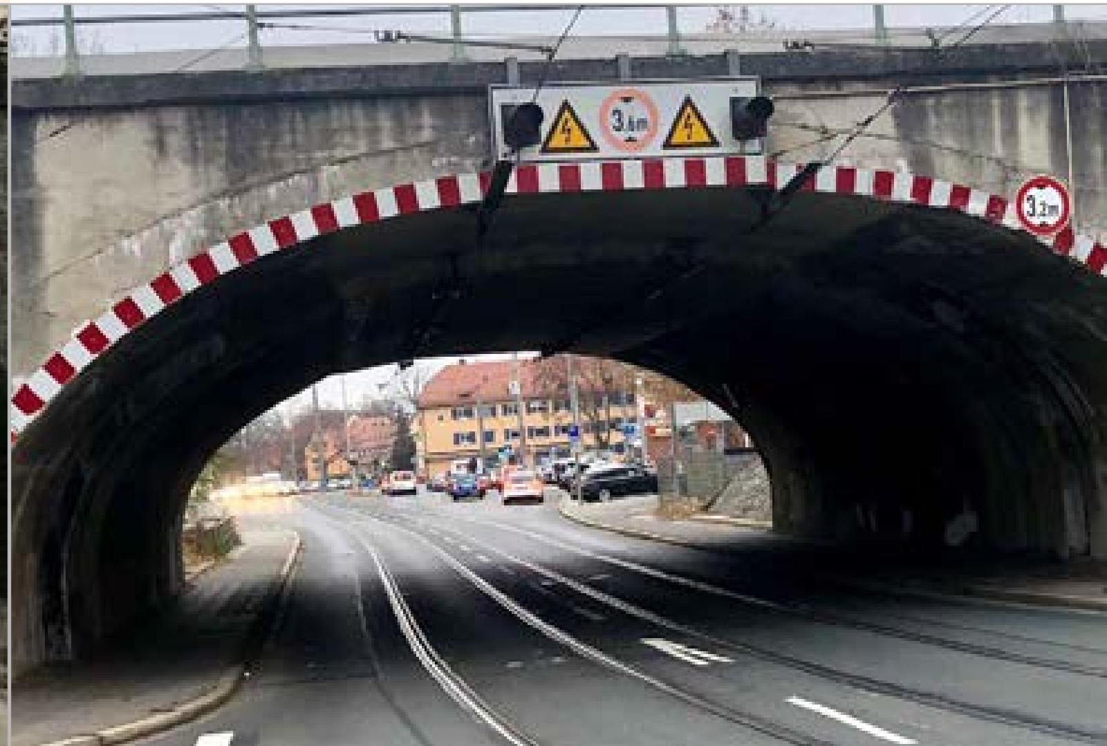
Eisenbahnbrücke am „Mausloch“
