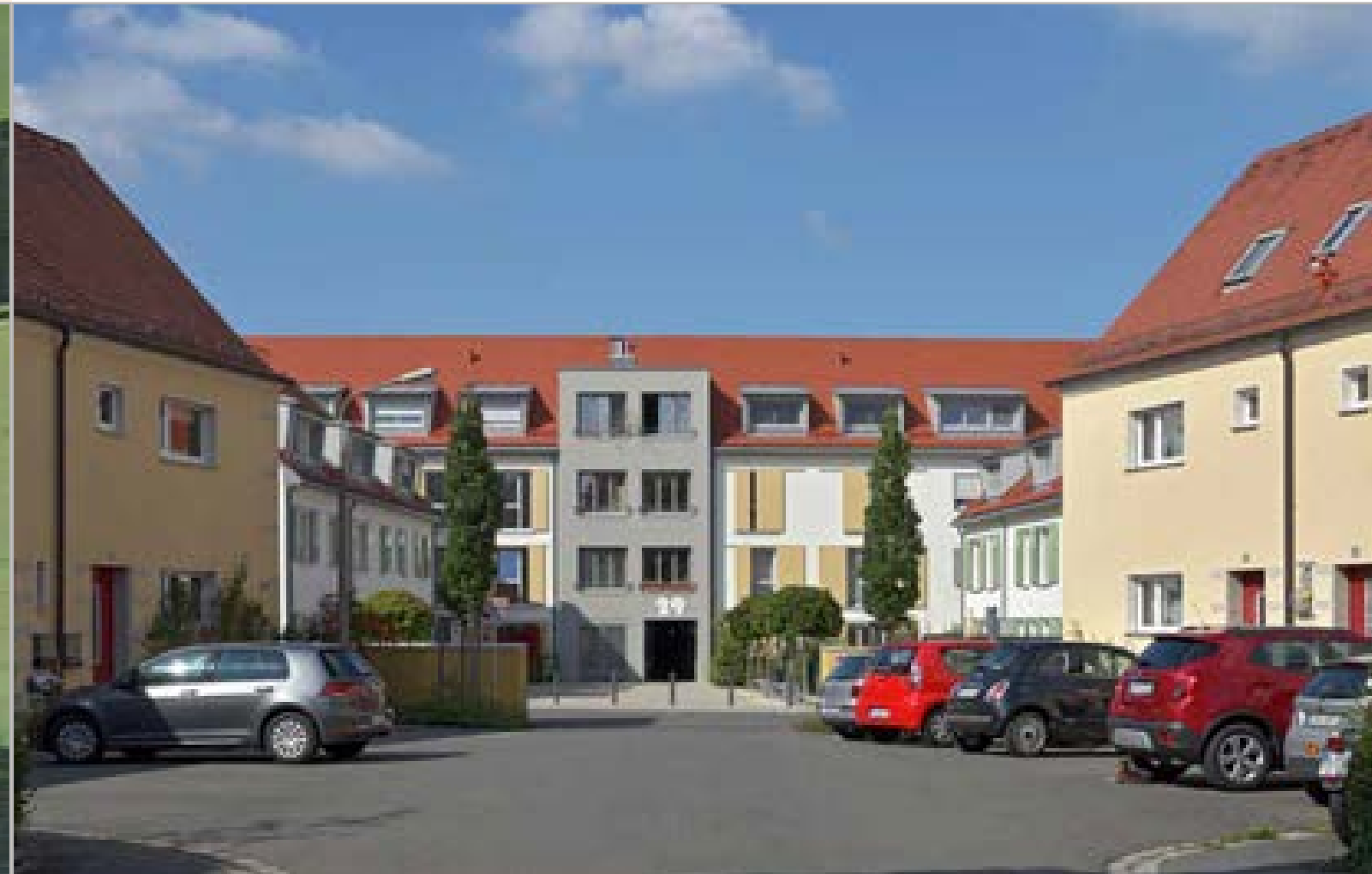
Heckenhof 21 - 29 Der 2014 errichtete Neubau passt sich bestens ein.
